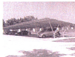
発電量は駐車場の規模によって、16.5kW、20kW、50kWなどのオプションがある。この写真は50kWの施工例
