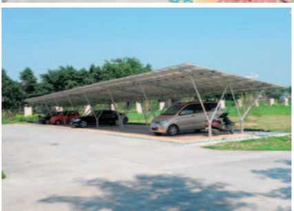
発電量は駐車場の規模によって、16.5kW、20kW、50kWなどのオプションがある。この写真は50kWの施工例
